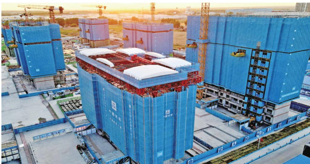
(上承第一版)系统通过创建标准化、自动化的人机协同环境,在业内率先实现混凝土施工工艺全链条智能化,打造全新的群体智能建造模式。该套系统的成功应用将混凝土工序用工数量缩减50%以上,工期缩短约30%,施工速度最快可达5天1层。
